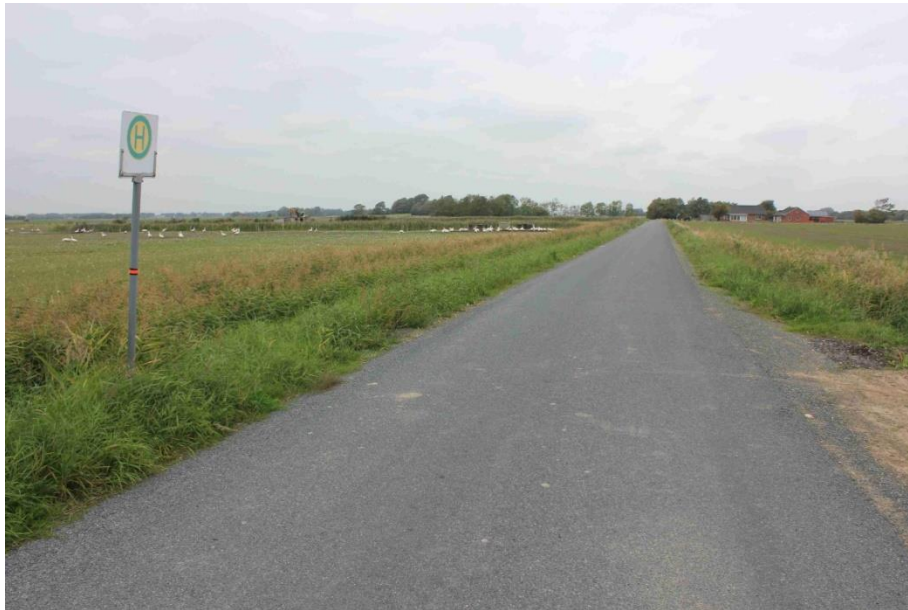
Foto 5: Dieser ausgebaute Wegeabschnitt in der Gemeinde Neukirchen wird auch von Schulbussen befahren.
