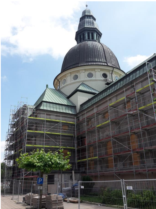
Abbildung 94: Sanierungsarbeiten am „Emsland-Dom“
