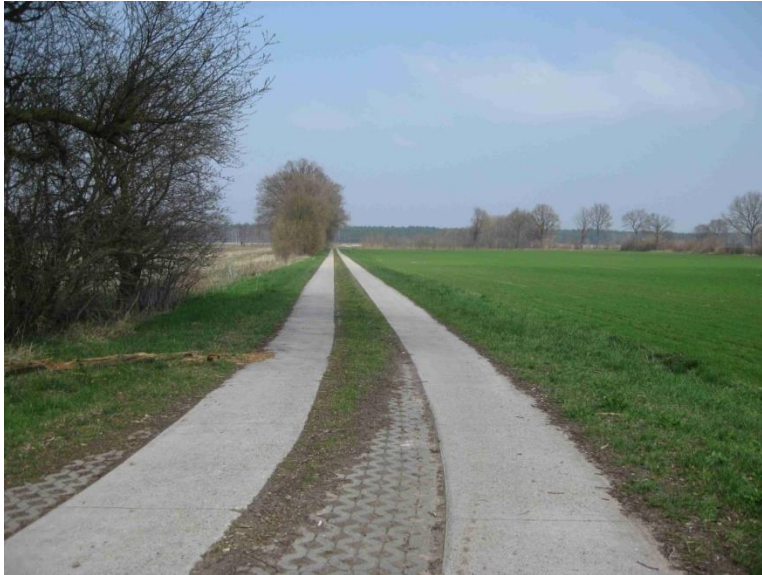
Foto 1: Beton-Spurbahn im Verfahrensgebiet Neetze (Landkreis Lüneburg)
