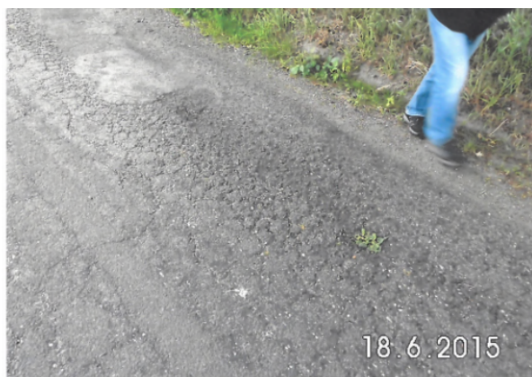
Fotos A8/1 und A8/2: Ausbaustrecken „Westerfeld“: Beschaffenheit der Asphaltdecke vor dem Ausbau (links) und der Weg nach dem Ausbau (rechts)
