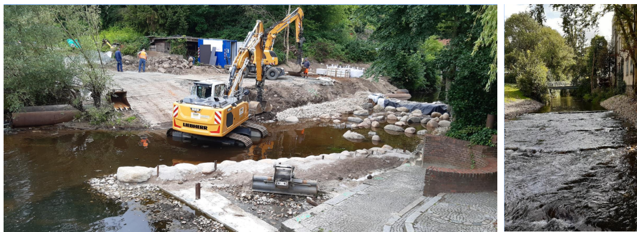
Fotos 3 und 4: Herstellung der Durchgängigkeit der Beste in der Stadt Bad Oldesloe (während der Bau- phase und nach Abschluss)
