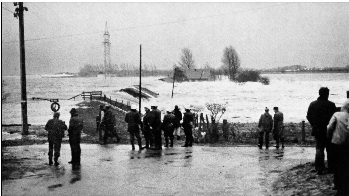
Abb. 10.5 Deichbrüche bei Holm/Haseldorfer Marsch am 03. Januar 1976 (max. eingeflossene Wassermenge rd. 6000 m<sup>3</sup> über 30 Min. bei Fallhöhen von 3,6 m bis 4,5 m) nach CARSTENS, 1976.
