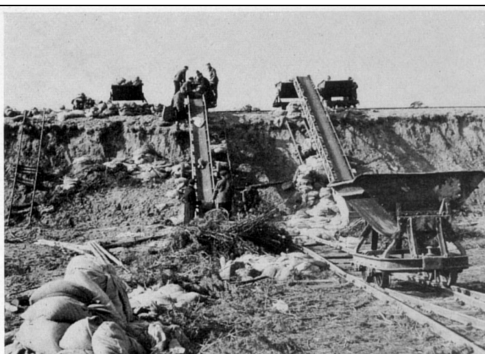
Abb. 9.5 Deichschäden nach der Sturmflut vom 16./17. Februar 1962 in der Gebietskulisse: II. Oldenburgisches Deichband hier: Augustgroden, ad-hoc Sicherungsarbeiten unmittelbar nach der Sturmflut
