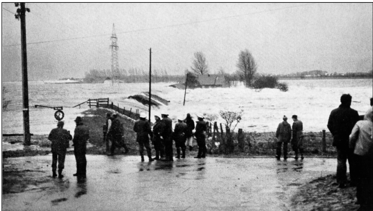
Abb. 10.5 Deichbrüche bei Holm/Haseldorfer Marsch am 03. Januar 1976 (max. eingeflossene Wassermenge rd. 6000 m 3 über 30 Min. bei Fallhöhen von 3,6 m bis 4,5 m) nach CARSTENS, 1976.
