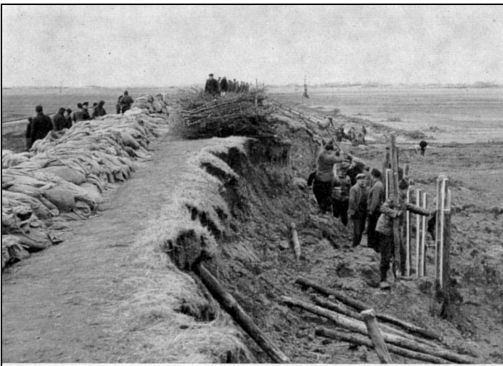
Abb. 40: Transport von Sand- säcken im Gleisbetrieb und mit Förderbändern zum Einbau für die Deichsicherung
