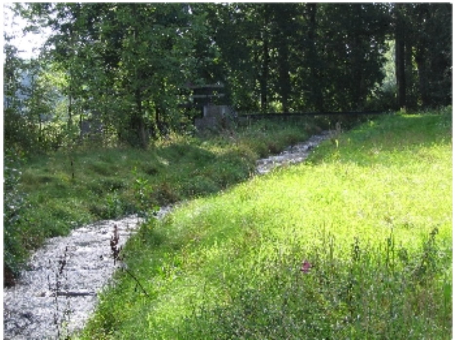
Foto t2-E1: Blockstein-Beckenpass zwischen Mühlenwehr und Mühlengraben an der Gartemühle
