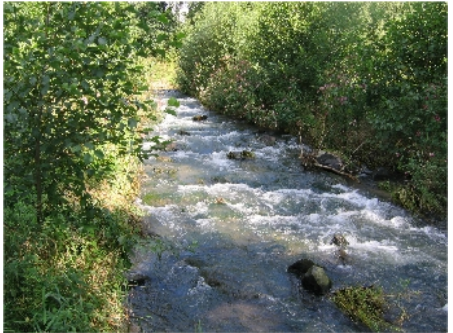
Foto t2-E2: Raue Sohlgleite an der Steinsmühle, zwei Jahre nach der Fertigstellung
