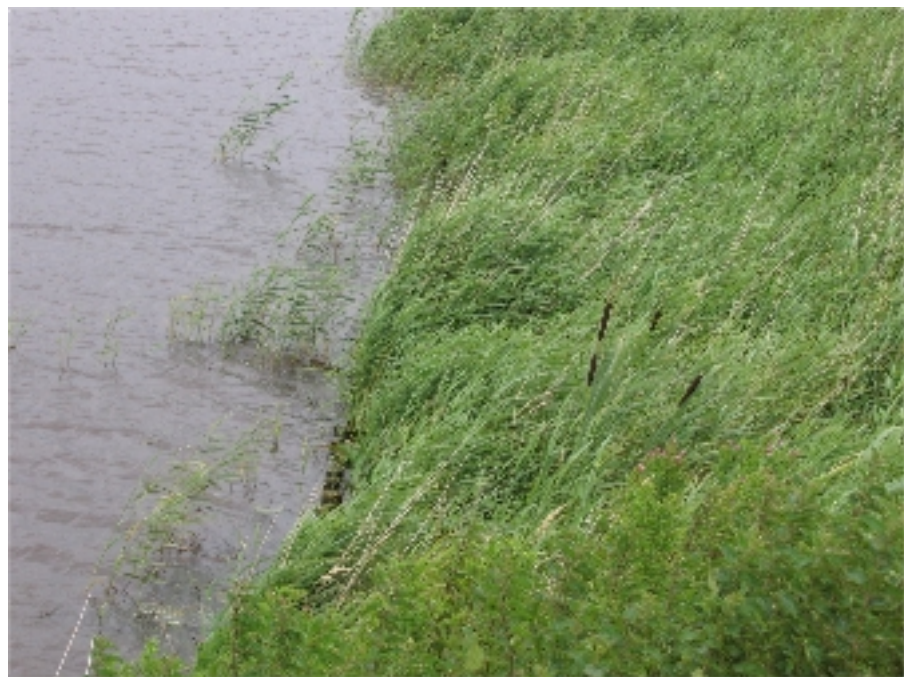
Foto t2-E4: Pfahlreihe zur Uferbefestigung und dahinterliegende Berme mit Schilf- und Rohrkolbenbewuchs
