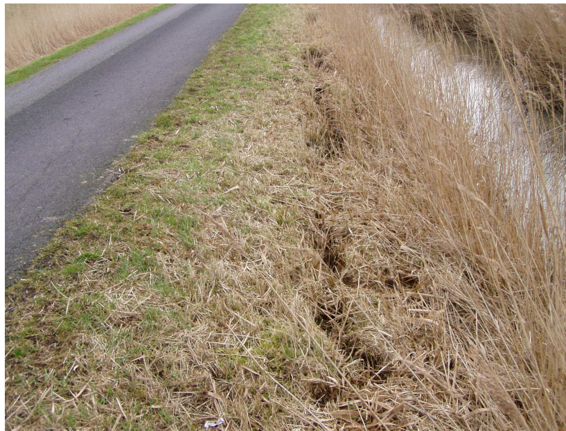
Foto r-E1: Böschungsabbrüche aufgrund von Bisamaktivitäten (Foto: Ruddeck, Stadt Tönning)
