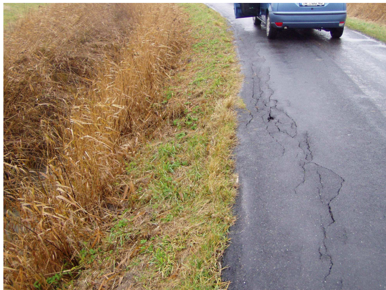
Foto r-E2: Sackungen und Kantenabbrüche aufgrund von Bisamaktivitäten (Foto: Ruddeck, Stadt Tönning)
