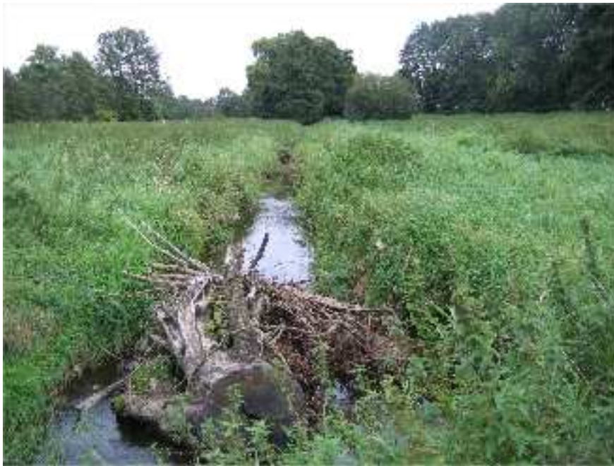
Foto t2: Förderung der eigendynamischen Entwicklung durch Einbringen von Totholz in der Ohlau (Foto: M. Bathke, 2007)
