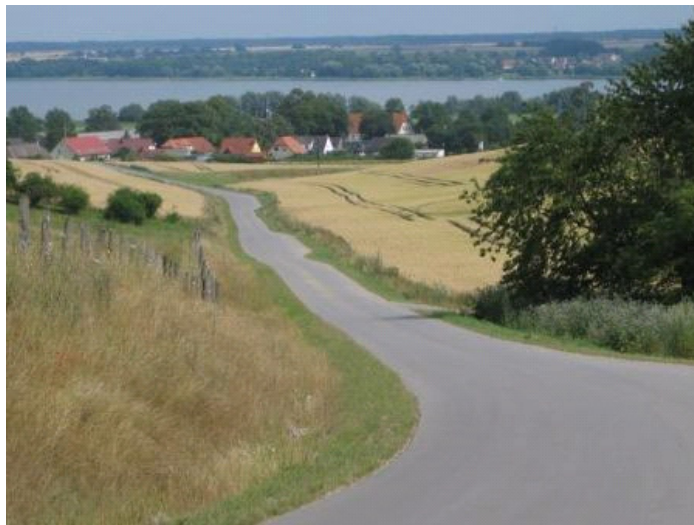
Ausgebauter Wirtschaftsweg am Kummerower See – Fördermaßnahme 125c: Wegebau (Foto: vtl 2009).
