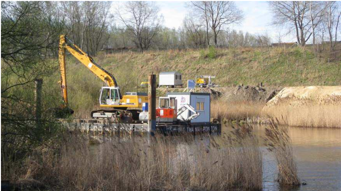
Foto 3: Entschlammung des Ostarms der Alten Süderelbe, Bagger auf Ponton mit Baucontainer und ELER-Schild nahe der Metha-Brücke
