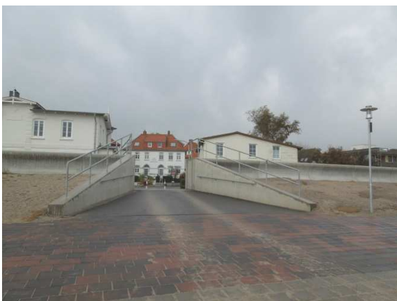
Abbildung 7: Bei Hochwassergefahr verschließbarer Deichdurchlass für Fahr- und Fußgängerverkehr in Ortslage Dahme mit Umkehrmauer auf der Deichkrone
