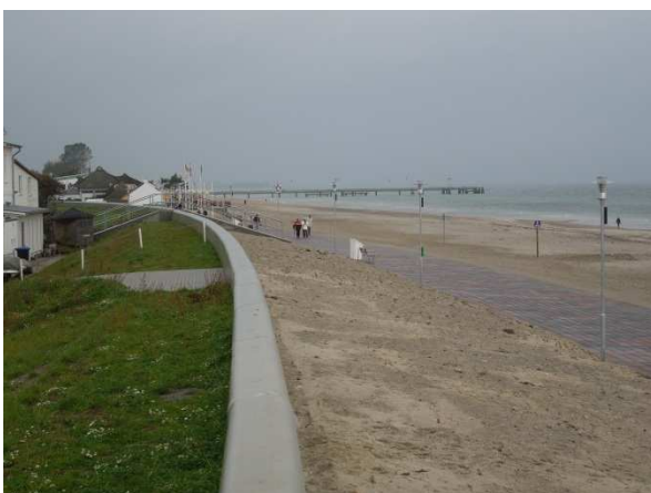
Abbildung 8: Deichkrone mit Umkehrmauer, Versorgungsweg am Deichfuß, anschließendem Sandstrand und Dahmer Seebrücke im Hintergrund
