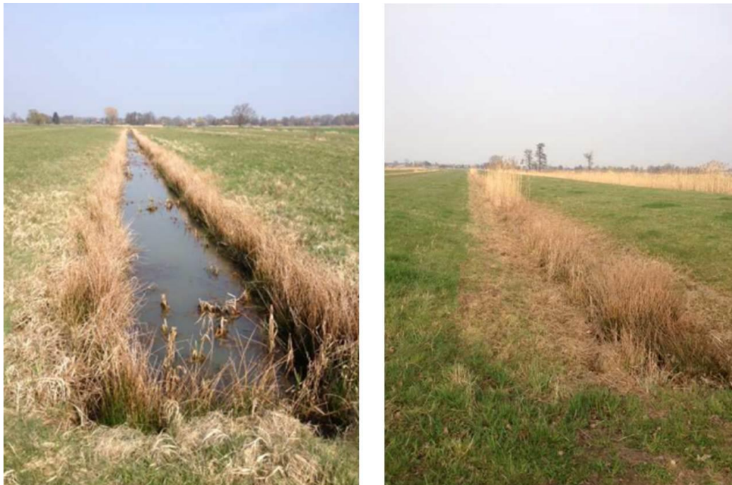
Foto 2: Geräumter (links, Graben 4) und ungeräumter Grabenabschnitt (rechts, Graben 18) im NSG Kirchwerder Wiesen
