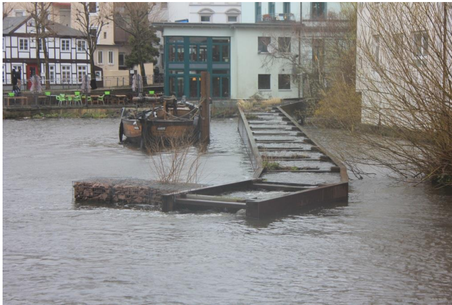
Foto 4: Fischtreppe zur Herstellung der ökologischen Durchgängigkeit am Serrahn-Wehr in Hamburg-Bergedorf
