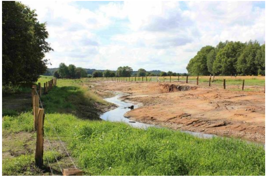
Foto 7: Maßnahme des Wasser- und Bodenverbandes an der Glasbek (Eigene Aufnahme, Juli 2012)
