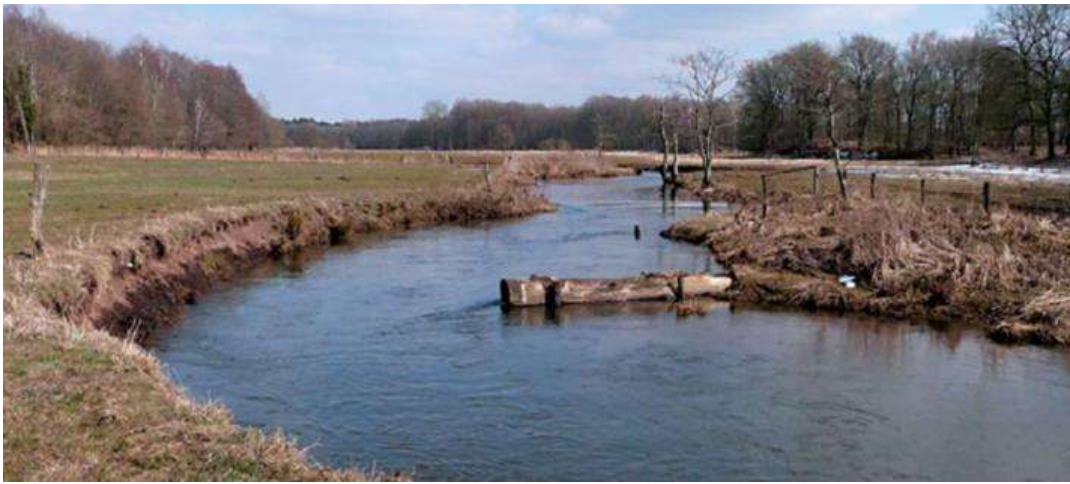
Foto 4: Holzeinbauten als Strömungsenker an der Stör
