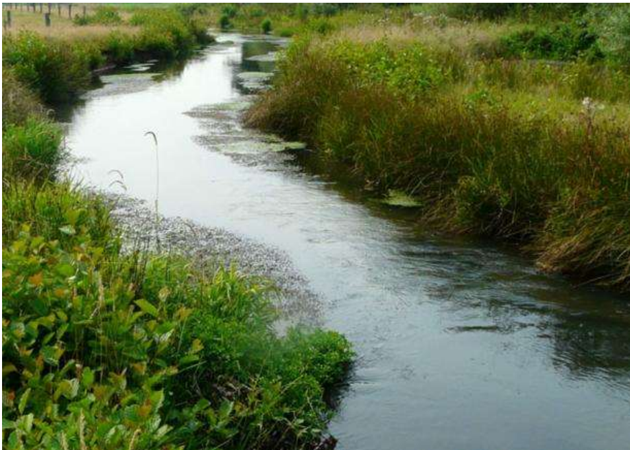
Foto 1: Laufverlängerung des Schafflunder Mühlstroms
