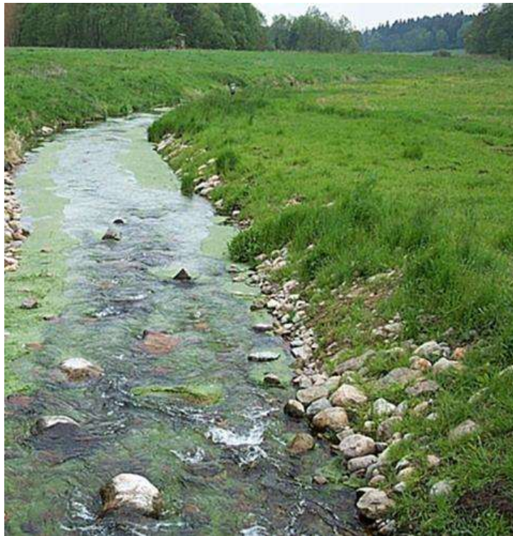
Foto 10: Sohlgleite in der Rantzau
