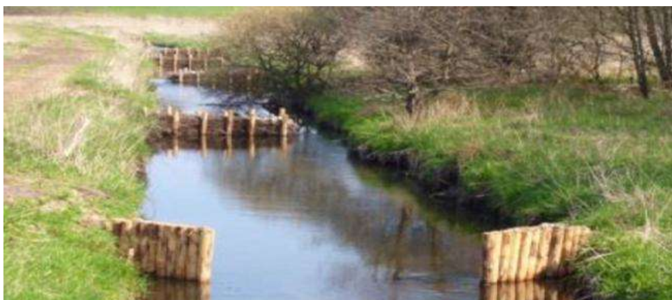
Foto 9: Strömunglenkende Maßnahmen an der Rantzau
